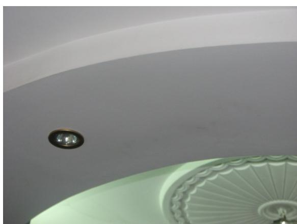
Công trình được thi công bằng tấm GH tính ổn định cao không bị rạn nứt mối nối.
