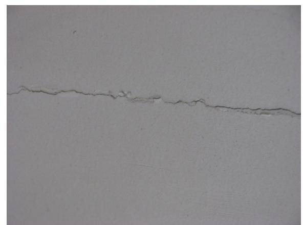
Công trình được thi công bằng tấm Xi măng sợi Cellulose và thạch cao bao giấy dễ bị rạn nứt mối nối.
