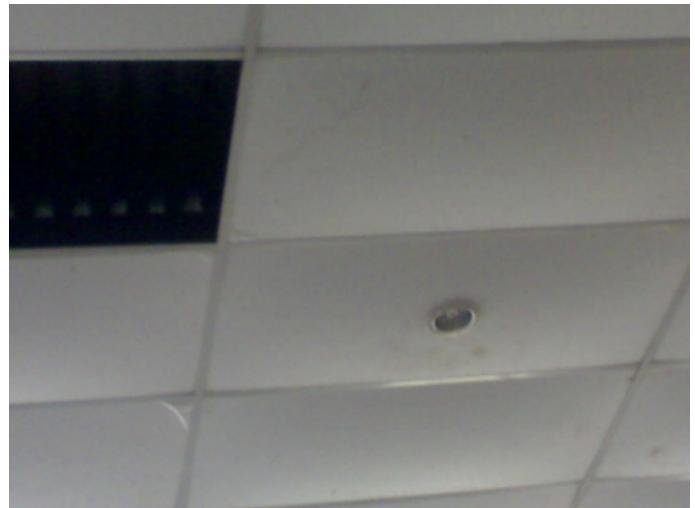
Tấm bao giấy khi gấp mốc hoặc ẩm ướt, giấy sẽ hút ẩm và mục vữa, tấm sẽ mất đi khả năng chịu lực dẫn tới sự cong vồng biến dạng.
