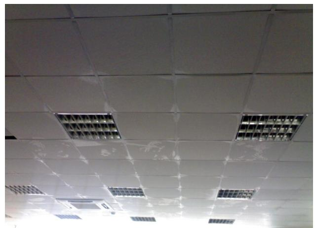
Tấm thạch cao như PVC bề mặt là nhựa nên dễ bị tụ nước trên bề mặt khi thời tiết nồm, dễ bị lão hóa, ố vàng và không bảo dưỡng được.
