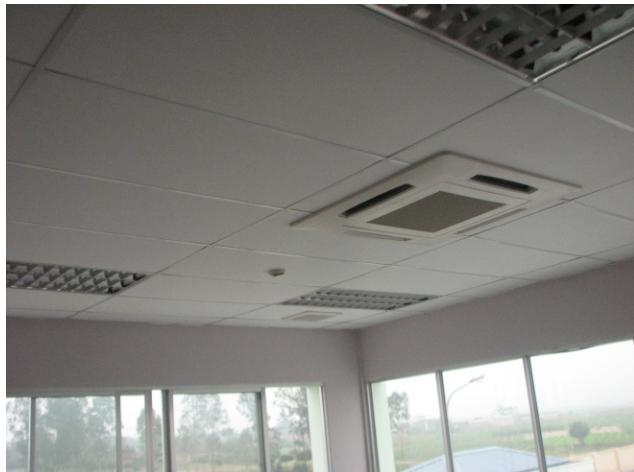
Dưới mái tôn, mái ngói, phòng xông hơi, dưới ống điều hòa, môi trường ẩm ướt thường xuyên với nguy cơ thấm dột cao. Tấm không bị cong vồng, biến dạng vì lõi được gia cường bằng vải sợi thủy tinh chịu lực, kháng nước, và có khả năng chống cháy.
